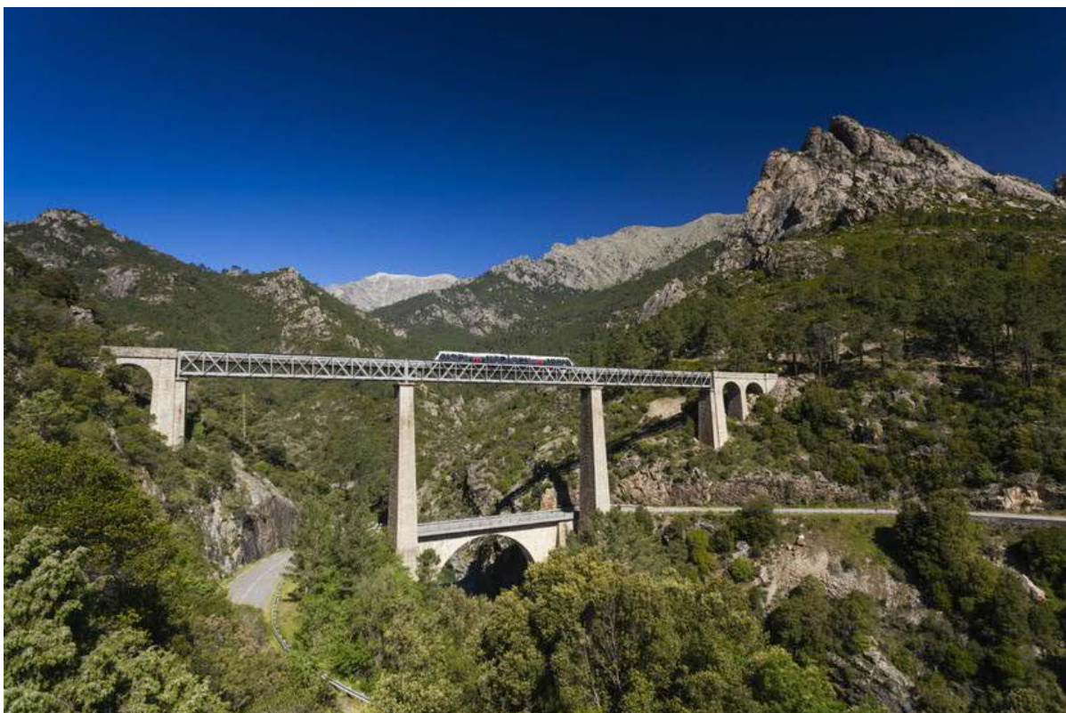
Auf der 160 Kilometer langen Reise überquert die Schmalspurbahn 34 Viadukte – hier der Pont du Vecchio, genannt «Pont Eiffel». (Bild: Walter Bibikow)
